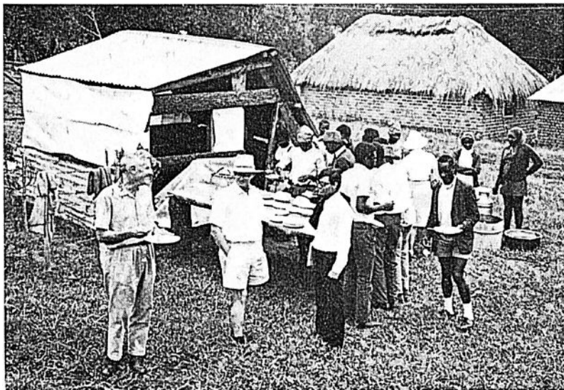
Utspisning vid det av arbetarna speciellt byggda matlagningshuset
