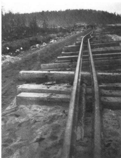
Järnvägen österut till Vita havet. När ryssarna retirerade drog två lok en slinga på släp som lämnade kvar ett krokigt skenpar på banvallen.
