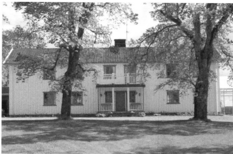
Stora huset på Trossnäs med ny balkong 2009
