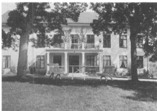
Huvudbyggnaden på Trossnäs efter renoveringen 1929
