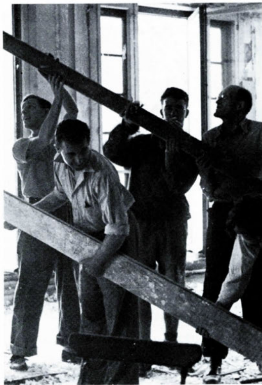
Construction de la scène du théâtre
