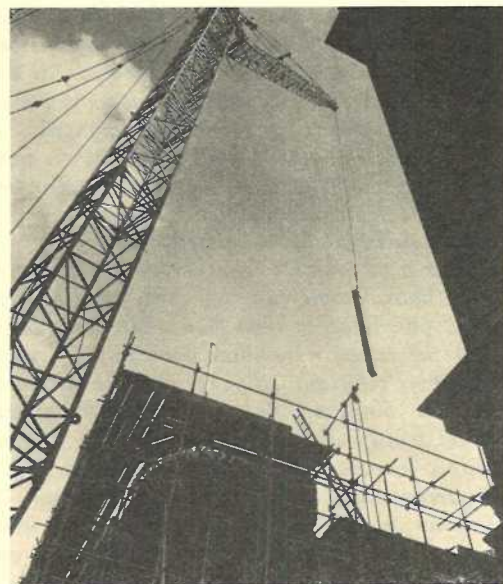
Le « Westminster » s'agrandit : deux étages supplémentaires seront érigés en superstructure sur le bâtiment actuel. Pendant le week-end une grue géante a hissé les poutrelles d'acier ; toute circulation avait été interdite dans la rue longeant le théâtre.
