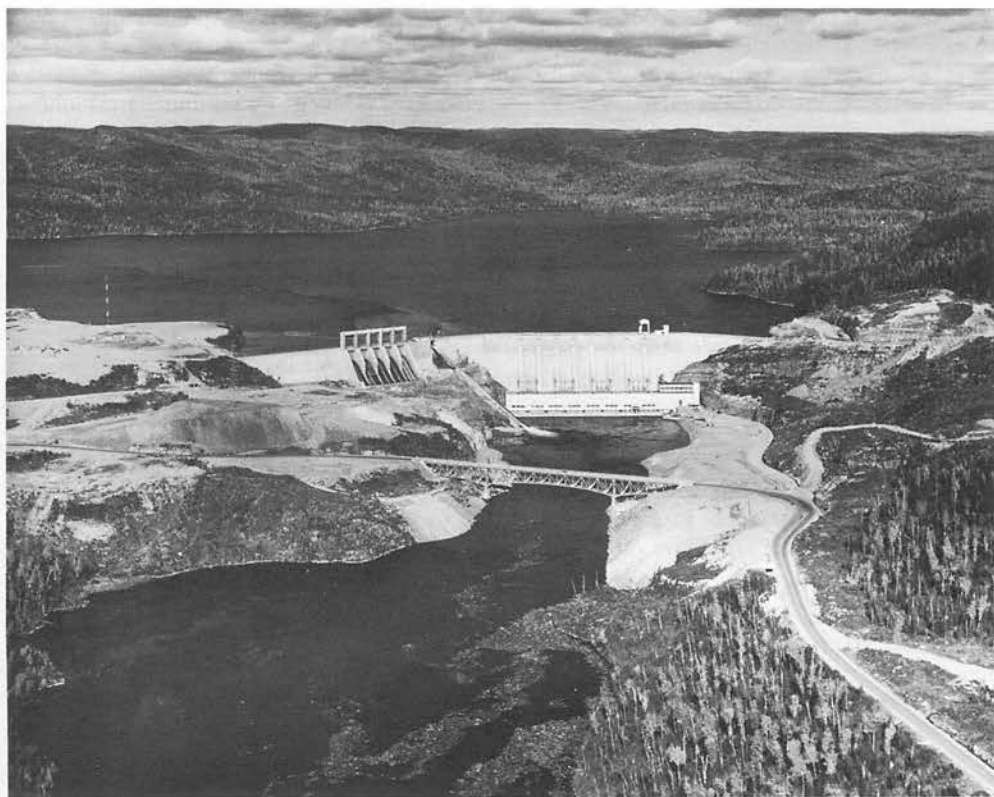
Vue aérienne du barrage Manic 2 : un paysage caractéristique du Québec d'aujourd'hui.
