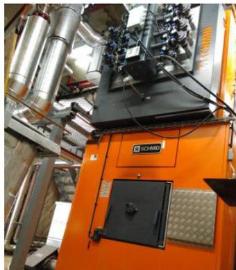
mit Holz und zu 20 % mit Heizöl befeuert wird. Die im Juli 2015 begonnenen Bauarbeiten dauerten ungefähr ein Jahr. Der Einbau einer solchen Anlage im relativ engen Kellerraum des Caux-Palace war ein heikles Unternehmen. Es galt etliche Schwierigkeiten zu überwinden, um das neue System installieren zu können.
