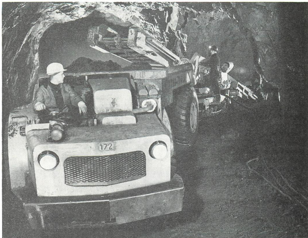
Die «Kiruna-Förderfahrzeuge» sind gebaut, um die Arbeit der Bergleute möglichst zu erleichtern. Sie entwickeln keine gefährlichen Abgase!
