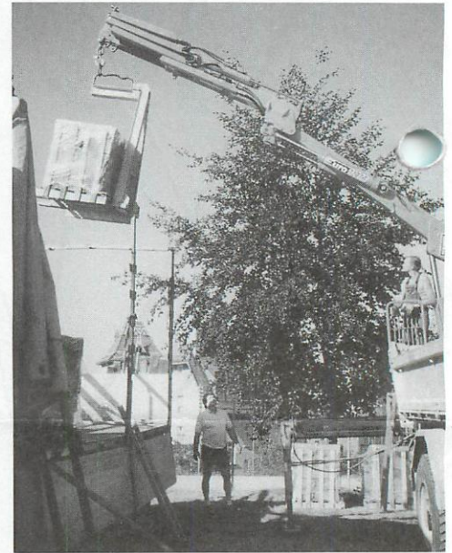
Die speziell angefertigten Ziegel aus Frankreich treffen ein
